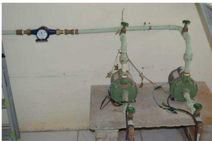
Figura 2 – Vista geral de um dos conjuntos de motobombas e do hidrômetro instalados para mediação da quantidade de água pluvial bombeada.
