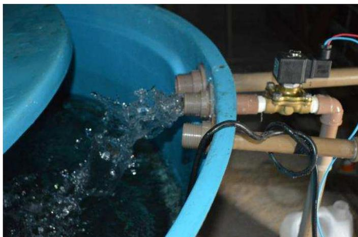
Figura 1 – Funcionamento e acionamento de uma das válvulas solenoides instaladas em um dos reservatórios de água pluvial superiores, em caso de falta de água pluvial.
