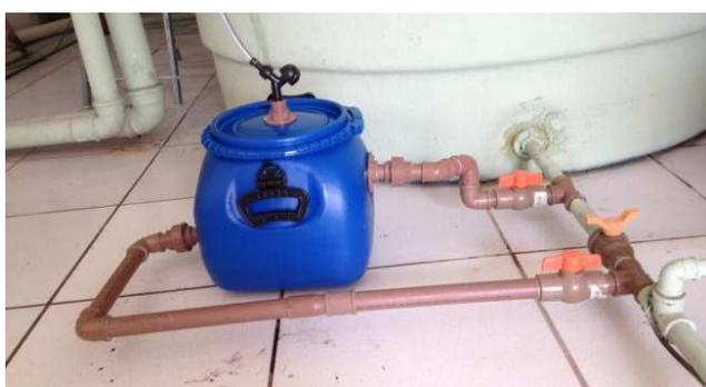
Figura 5 – Vista do filtro rápido de areia instalado na saída da cisterna
